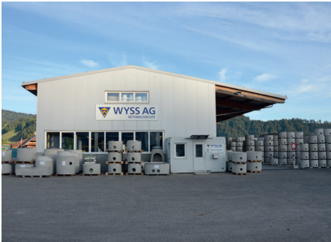
Производственная и складская зона компании Wyss AG Betonschächte в Шюпбахе в Эмментале, Швейцария
